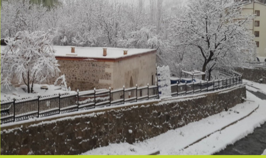
İspir Kadıoğlu Medresesi Restorasyon İşi
