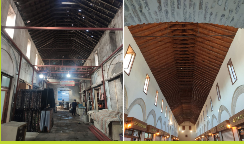
Ali Münif Yeğenağa Caddesi 3.Etap Sokak Sağlıklaştırma Restorasyon Uygulaması İşi
